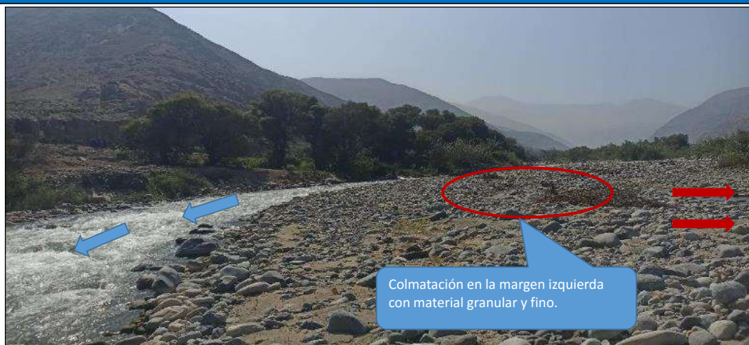
FIGURA N°01: RIO CHANCAY - HUARAL COLMATADO EN EL SECTOR SANTO DOMINGO, CON LA PRESENCIA DE: VEGETACIÓN, ARENA FINA Y MATERIAL GRANULAR; LAS CUALES DEBEN SER DESPLAZADOS HACIA AMBOS MARGENES PARA MANTENER SU SECCIÓN HIDRÁULICA .
